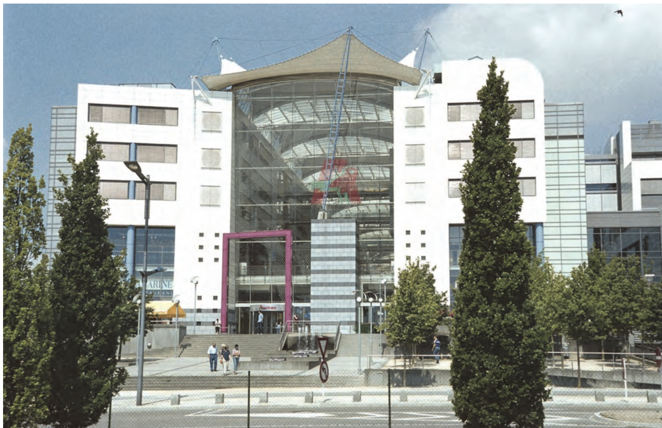
Une construction moderne au Kirchberg
